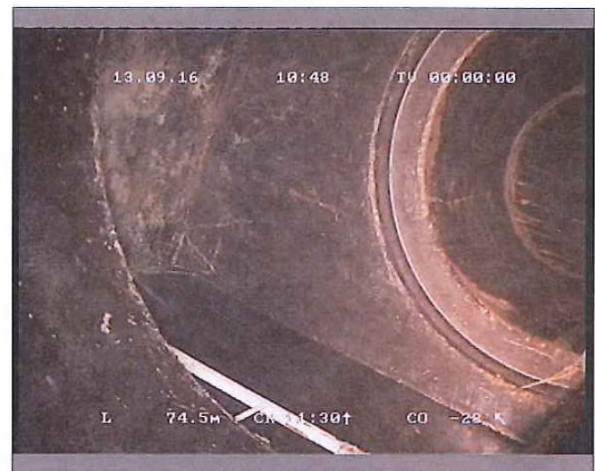
Fotografia: 2_2A 74,58m, Ø Pozzetto intermedio 100 (CON SALTO DI QUOTA)
