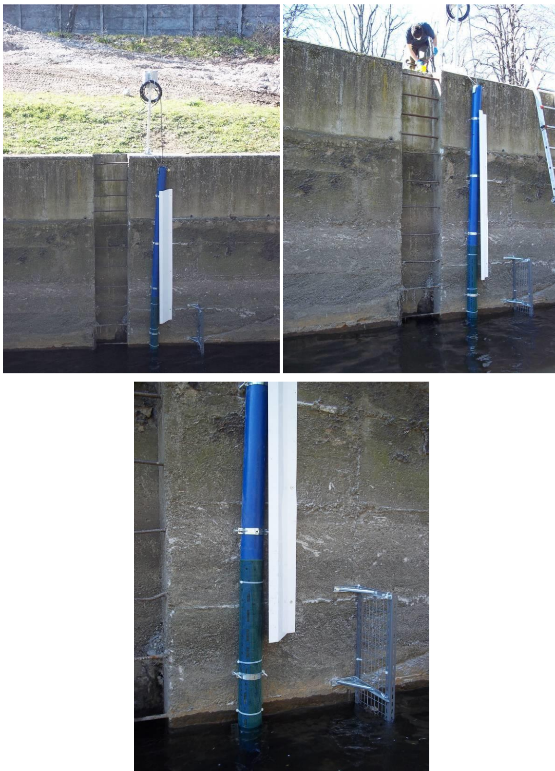
Figura 52 – Installazione della sonda S/N 13M101703 all'interno del T. Seveso
