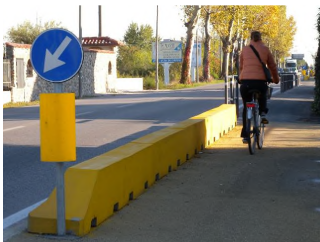
Figura 28 – Barriera mini new-jersey laterale di protezione della pista ciclabile
